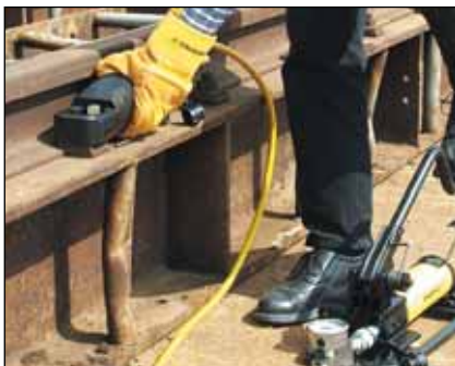
◀ Ruostuneen mutterin irroitus rataaksesta Enerpac mutterimurskaimella.
